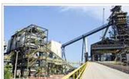
INAUGURAÇÃO DA EXPANSÃO DA USINA
