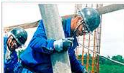
INÍCIO DAS OBRAS DE EXPANSÃO
