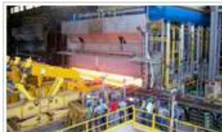
INÍCIO DE OPERAÇÃO DO SEGUNDO FORNO DE AQUECIMENTO LTQ
