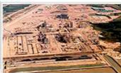
INÍCIO DA CONSTRUÇÃO CIVIL
